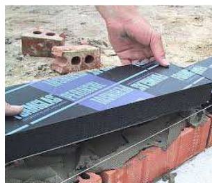
Aislamiento base muro Foamglas
