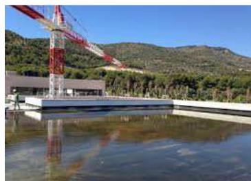
EPDM RESITRIX autoadhesivo. Prueba de estanqueidad
