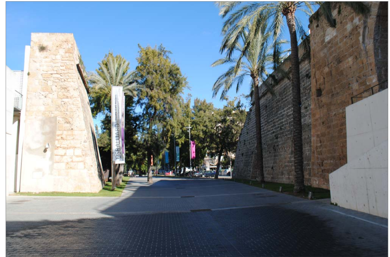
VISTAS DE LA UBICACIÓN. ENTRADA ES BALUARD. COLOCACIÓN DEL PABELLÓN ENTRE MUROS
