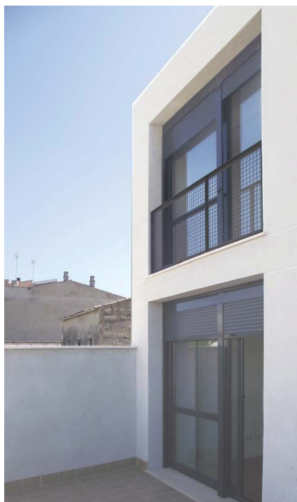
_Terrassa vivenda planta primera (façana interior)
