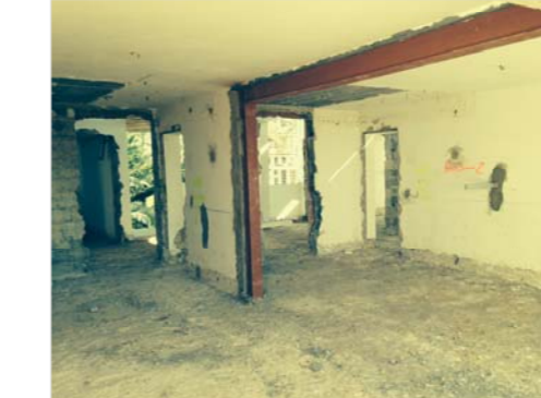
Foto 6. Execució de l'habitació Suite. Substitució de mur de càrrega de bloc per portic metàl·lic per guanyar amplitud. TERRASSA NO TRANSITABLE
