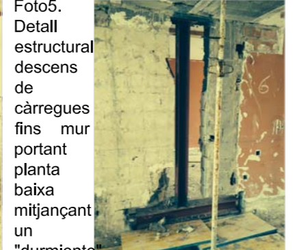
Foto5. Detall estructural descens de càrregues fins mur portant planta baixa mitjançant un "durmiente"
