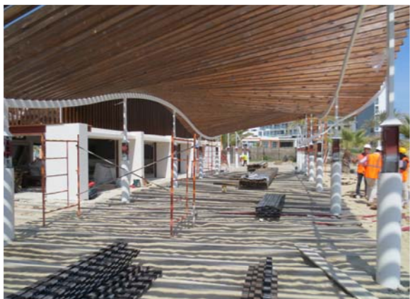
Foto 9. Execució de les obres
