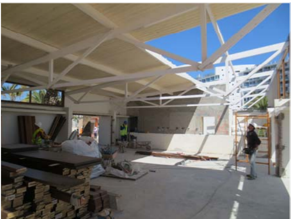
Foto 8. Interior menjador durant les obres
