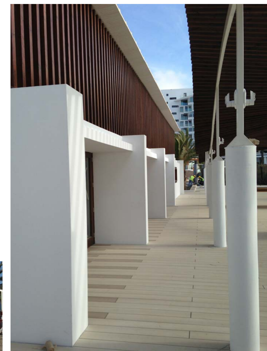
Foto 1. Separació entre pèrgola i volum tancat.
