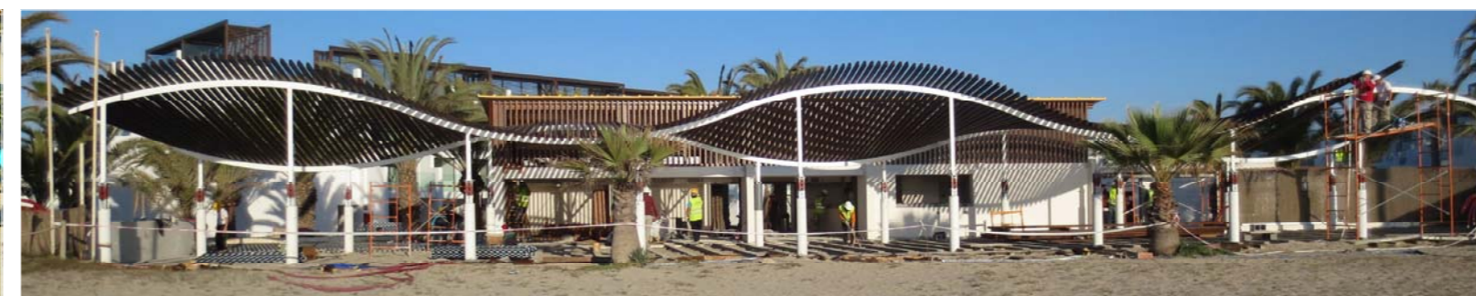
Vista frontal pèrgola durant l'execució de les obres
