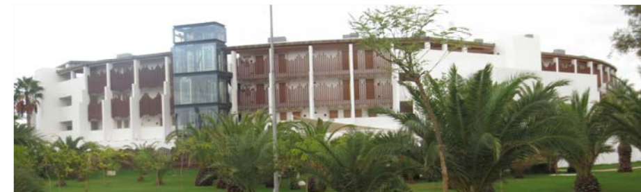
Foto 6. Projecte façana bloc semicircular Club. La barana de llistons de fusta simula les barres d'un equalitzador musical, per fer referencia a la temàtica
