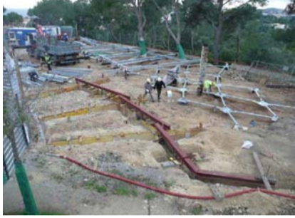
ESTRUCTURA SUELO. Vigas acero galva. HEB240 borde no galva. Viguetas IPE120-160
