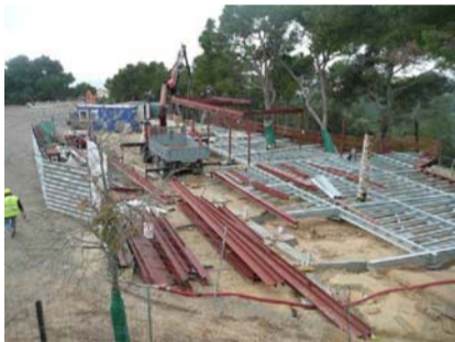
ESTRUCTURA PILARES Y PLETINAS. Pilares #100.5, estructura pletinas en tienda. Pilares pérgola Ø100.5
