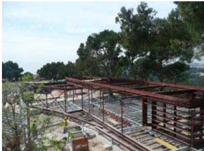
ESTRUCTURA CUBIERTA. Vigas HEB240, Vigas pérgola 1/2 IPE300. Viguetas de madera de abeto 10x20 c/60
