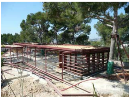
CUBIERTA. Acabada con planchas acero corten. Platina superior HEB240 de remate cubierta. Pérgola viguetas de pino rojo 23x7
