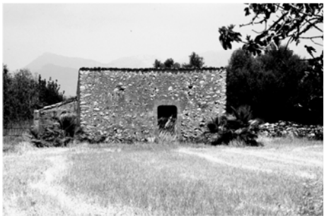
CONSTRUCCIÓ TRADICIONAL DE L'ENTORN Un mur gruixut de pedra recinta, configura i caracteritza l'edificació
