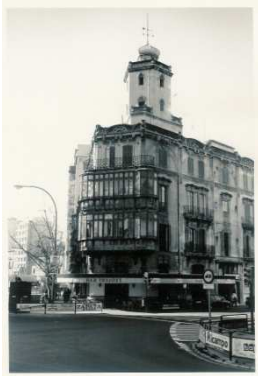
Edifici Bar Triquet
